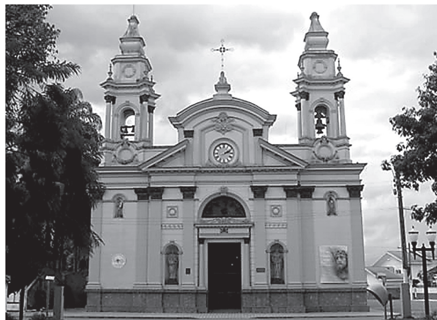
Basilica de Bom Jesus tem projeto de restauro feito pela UNITAU
